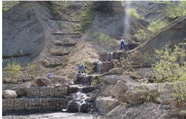
За предотвратяване на свлачище в Природен парк Българка са изградени тераси
